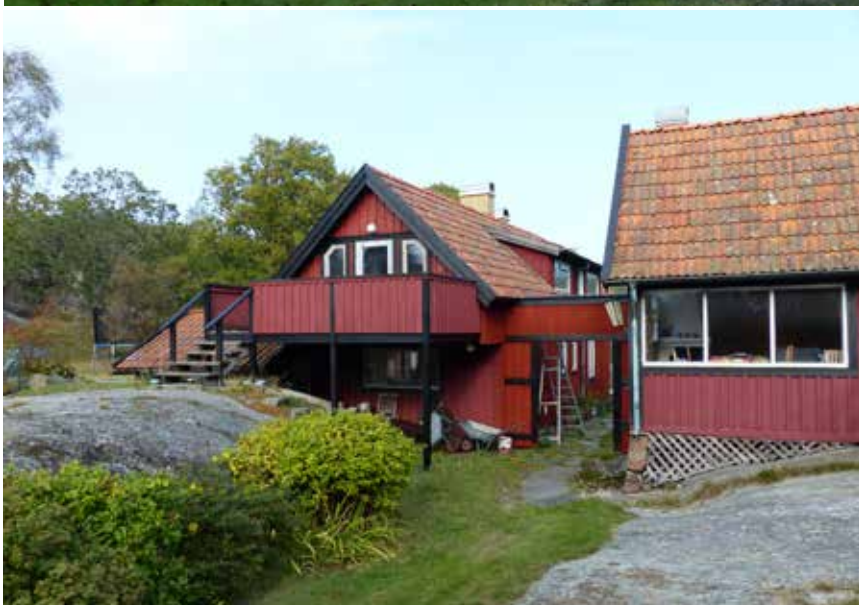
Ekonomibyggnaderna från väster, F.d. ladugården till vänster i bild. En liten port finns mellan husen.
