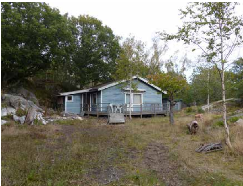
Byggnadens södra fasad.
