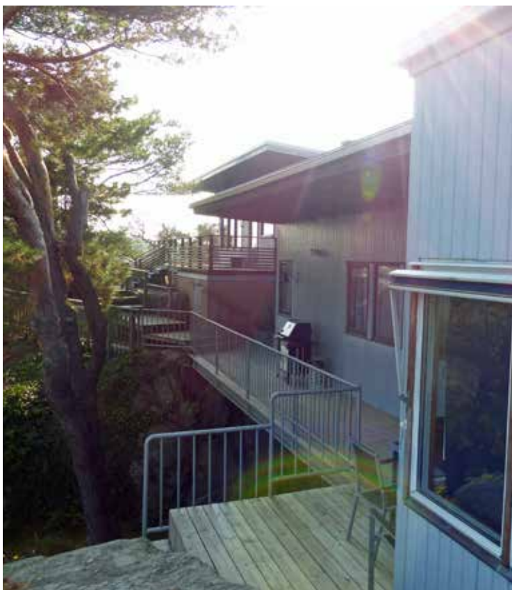
Verandan, ett enkelt trädäck med staket i stålprofiler.
