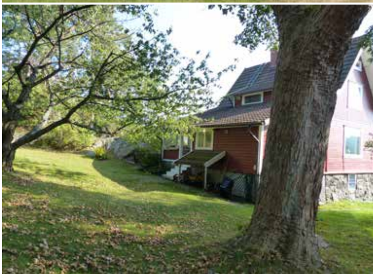
Överst: från sydväst, nederst baksidan. Huset är utbyggt och verandor inbyggda.
