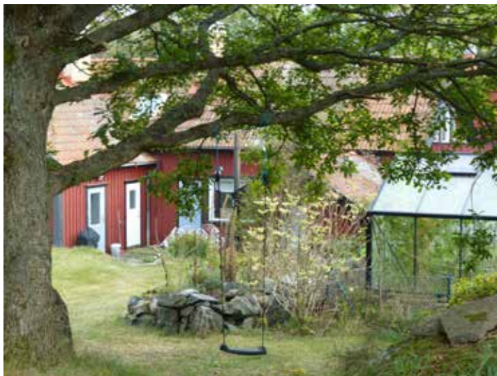
Nedan: Baksidan av f.d. ladugården. Muren har rasat, den enda som är skadad.
